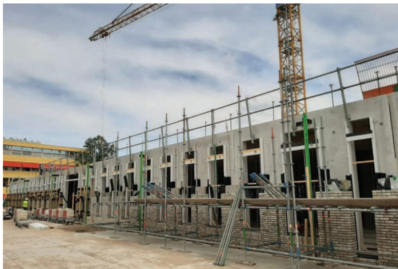
▲ Juni: aanvang metselwerk begane grond.
