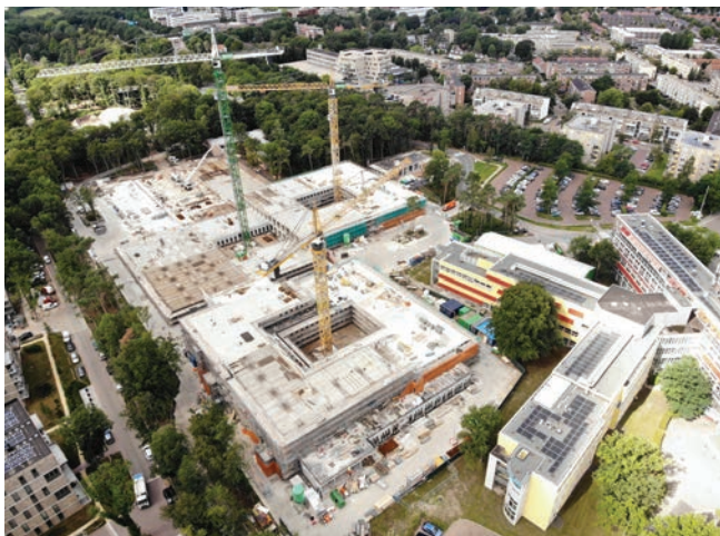
▲ Juli: luchtfoto van de nieuwbouw.
