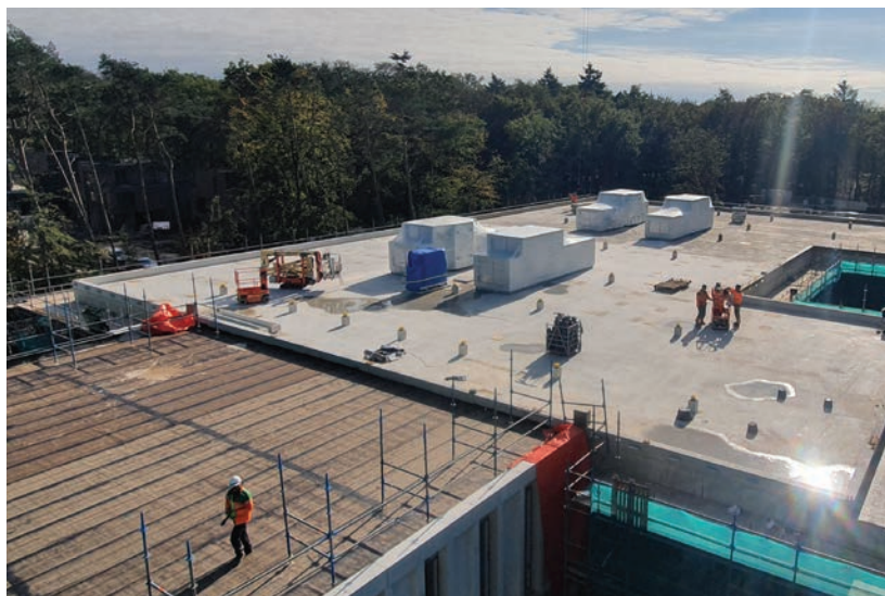
▲ Oktober: start bouw techniekruimte bouwdeel B. Links staan de ingepakte luchtbehandelingskasten.
