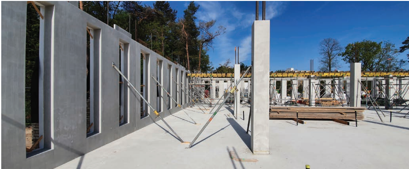
▲ April: de eerste prefab elementen worden geplaatst voor de begane grond (in dit geval bouwdeel C).
