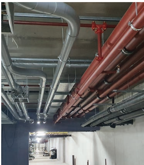
▲ September: installaties worden aangebracht in de keldergang.
