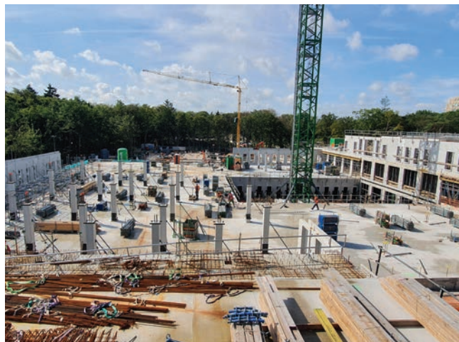
▲ September: bouw eerste verdieping bouwdeel B (OK-complex).
