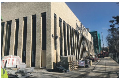
▲ Maart: de gevel wordt steeds zichtbaarder nu de steigers worden afgebroken.
