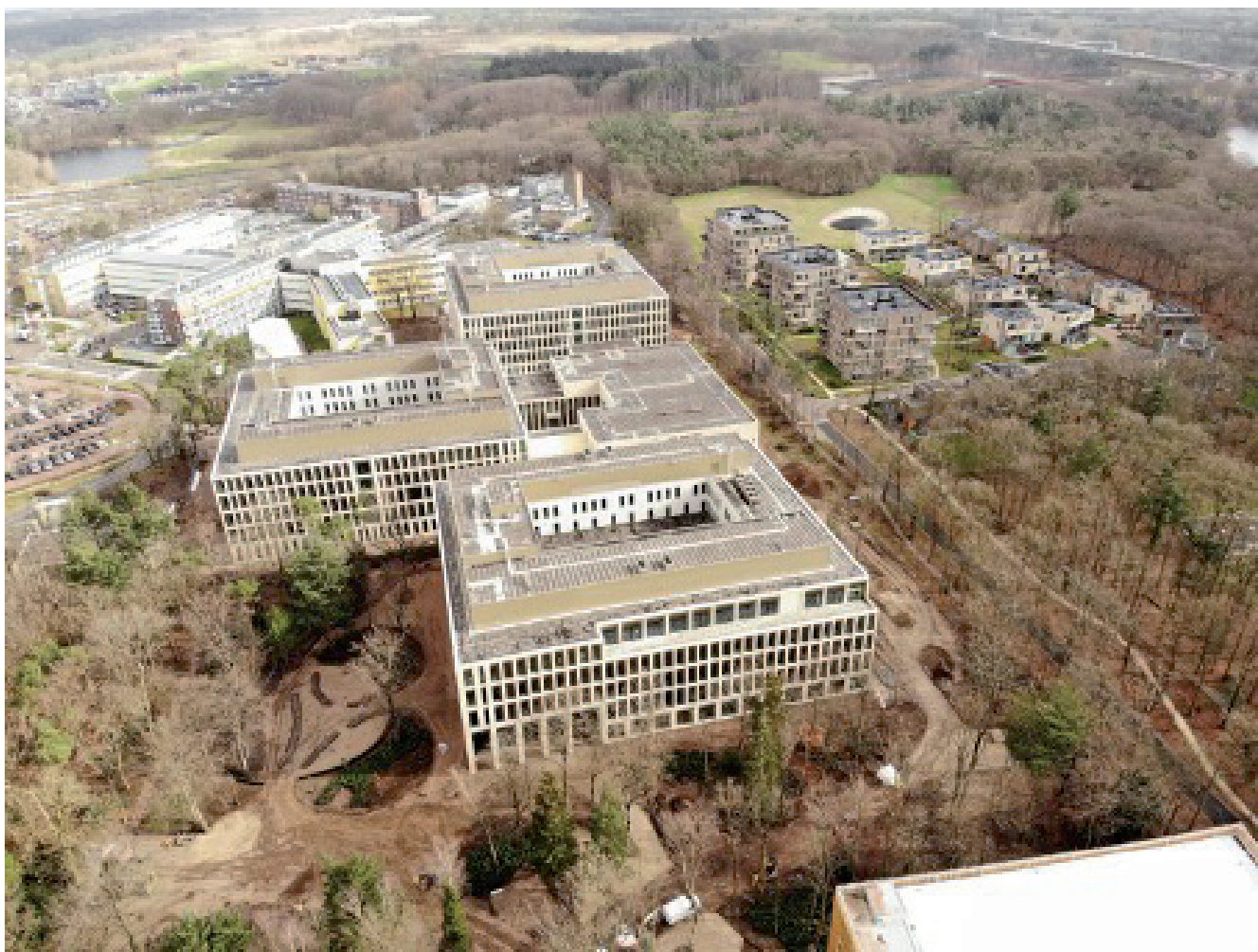
Nieuwbouw Tergooi MC in aanbouw
